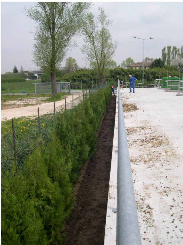
Figura 2. Particolare di piantumazione attorno il centro di stoccaggio
